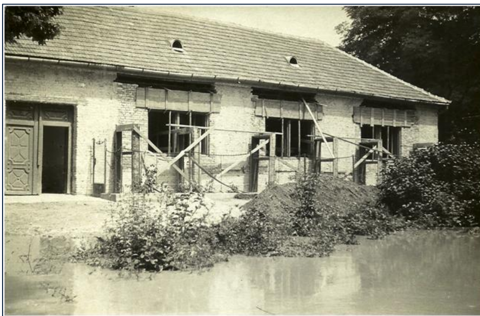
Povodeň v roku 1958 - rozostavaná fara
